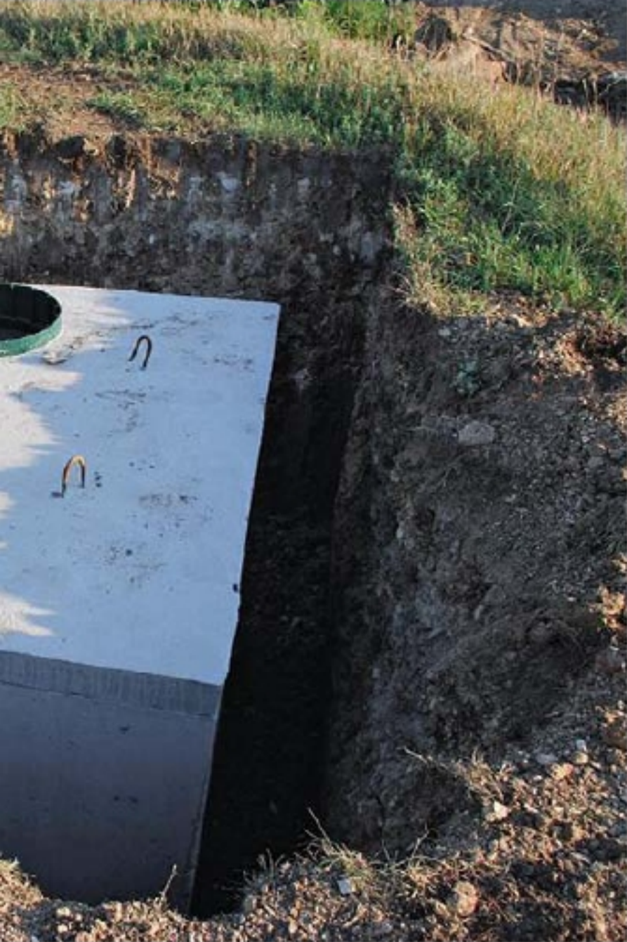
▲ L'entrée du bunker reste le point faible: l'abri est rejoint en descendant un long couloir où risque de s'accumuler l'eau en cas de fortes pluies.
